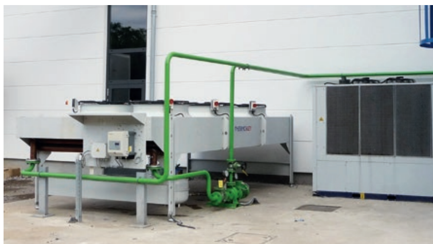
封闭式循环冷却水装置 Układ schładzania wody obiegowej (chłodzącej regenerat) w układzie zamkniętym
